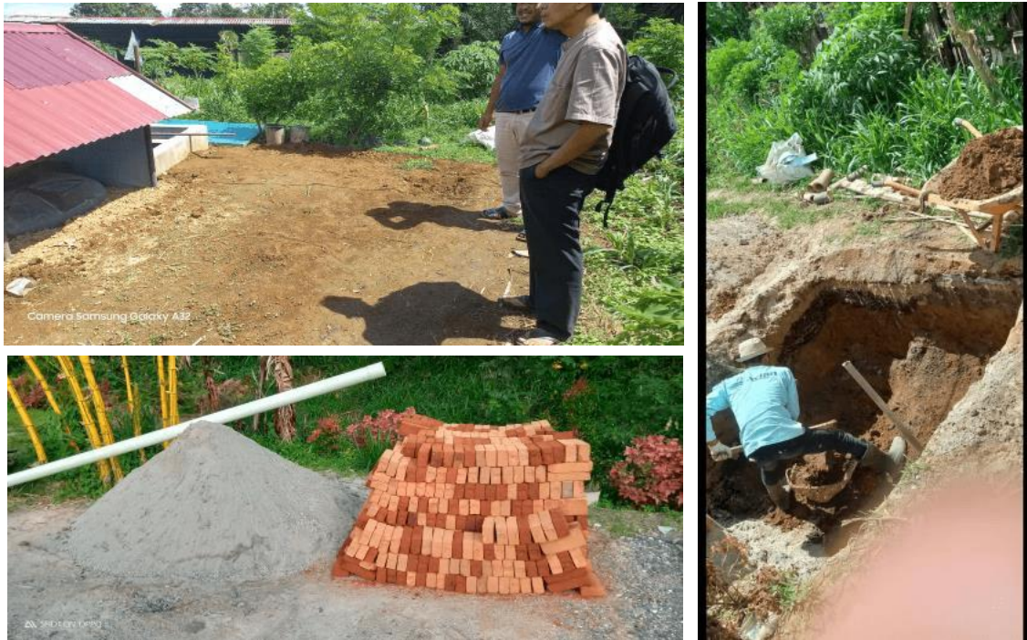
Gambar 3. Proses Pembangunan Digester dengan Kapasitas Generator
